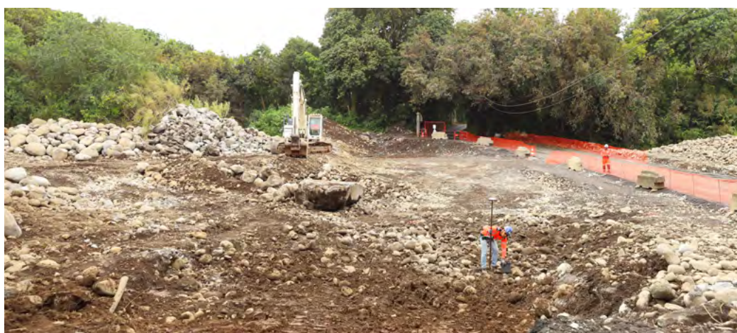
Chantier Îlet Coco
