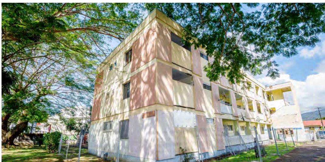
Travaux de dépollution des immeubles Labourdonnais 22 en cours
